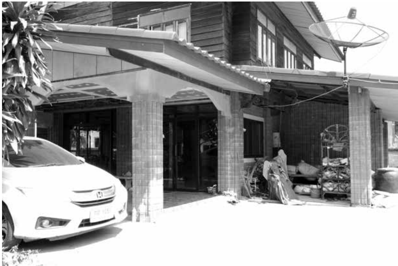
ภาพที่ 10 การปิดล้อมหรือกั้นพื้นที่แบบทึบ โดยใช้การก่ออิฐถือปูน เรือนพักอาศัยพื้นดิน จังหวัด ร้อยเอ็ด (ที่มา: อนุรักษ์ สัตนันทน์, ถ่ายเมื่อ 24 กรกฎาคม 2558)
