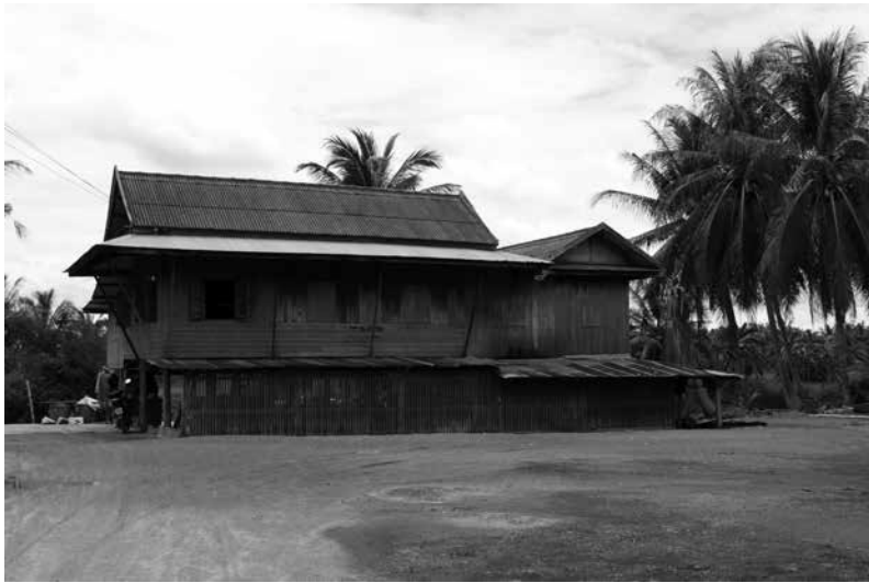
ภาพที่ 5 การปิดล้อมหรือกั้นพื้นที่ได้ทุนเรือนแบบบางเบา โดยใช้ไม้ตีตามแนวตั้งแบบโปรง เรือนพักอาศัยพื้นถิ่น จังหวัดเพชรบุรี (ที่มา: ญัฐติ สัตนันท์, ถ่ายเมื่อ 18 มิถุนายน 2558)
