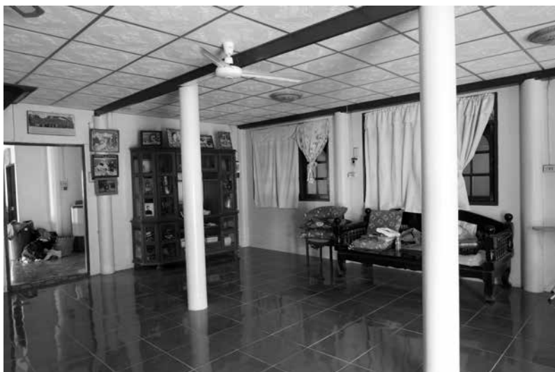
ภาพที่ 7 การปรับปรุงพื้นที่ใต้ถุนเรือนโดยการปูกระเบื้อง เรือนพักอาศัยพื้นถิ่น จังหวัดเพชรบุรี (ที่มา: ณัฐวดี สัตนันท์, ถ่ายเมื่อ 18 กันยายน 2559)
