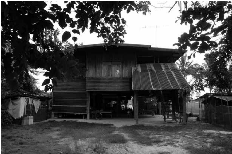
ภาพที่ 6 การปิดล้อมหรือกั้นพื้นที่ได้ทุนเรือนแบบบางเบา โดยใช้สังกะสี เรือนพักอาศัยพื้นถิ่น จังหวัดร้อยเอ็ด (ที่มา: ญัฐติ สัตนันท์, ถ่ายเมื่อ 26 กรกฎาคม 2558)
