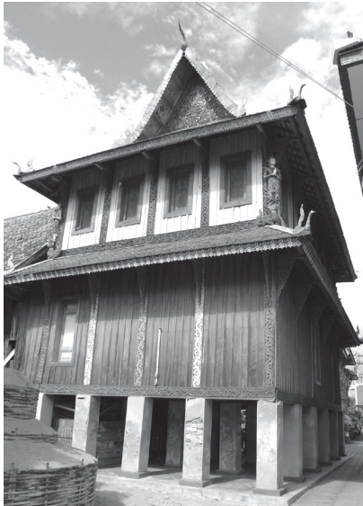
รูปที่ 5 หอไตร วัดบ้านหลุก อ. เมือง ลำพูน
