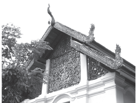
รูปที่ 12ก องค์ประกอบหลังคา วัดแม่แรง
