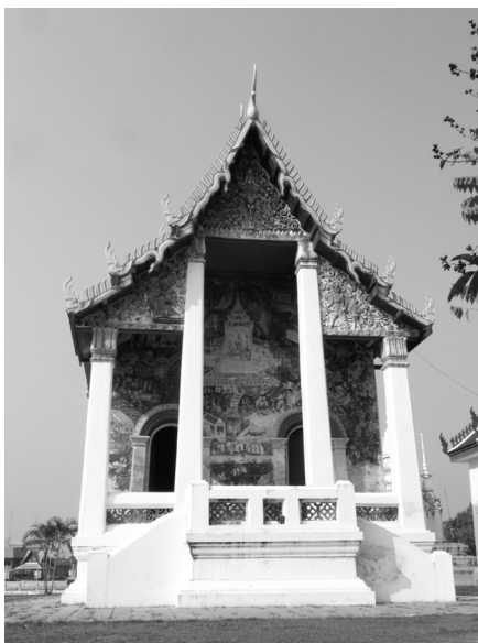
ภาพที่ 1 การเขียนภาพที่ผนังด้านนอกอาคาร วิหาร วัดอุโปสถาราม
