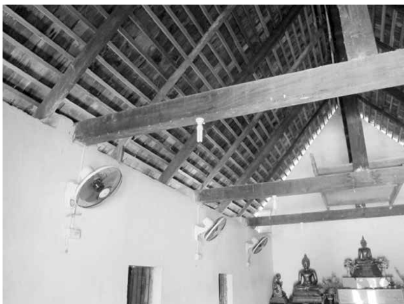
รูปที่ 8 การก่อผนังหนาเพื่อรับน้ำหนักโครงสร้างจากส่วนบนของโครงสร้างหลังคา แบบฉบับเฉพาะช่างญวนในการรังสรรค์ผลงาน ตัวอย่างที่วัดโคกนาดี อ.โคกศรีสุพรรณ จ.สกลนคร
