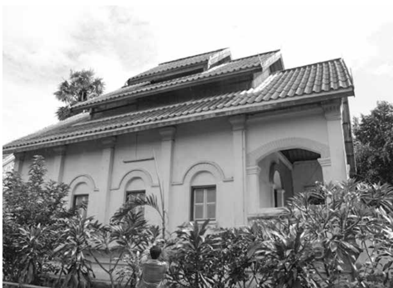
รูปที่ 16 สิมแบบฝีมือช่างญวนที่เก่าสุดในทางหลักฐานคือที่วัดยอดลำธาร อ.โพนนาแก้ว จ.สกลนคร ใช้ศิลปะแล่งเป็นวัสดุหลักในการก่อสร้าง
