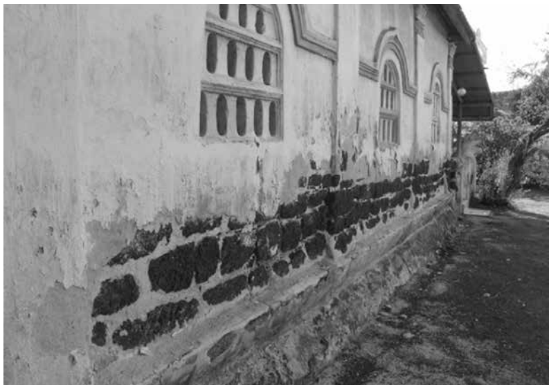
รูปที่ 7 วัสดุโคลาแลงคือเงื่อนไขพิเศษในการก่อสร้างอาคารตามแบบฉบับของฝีมือช่างญวน ที่จะต้องใช้โคลาแลงเท่านั้นกับการขึ้นโครงสร้าง ตัวอย่างที่วัดสะพานคำ อ.เมือง จ.สกลนคร
