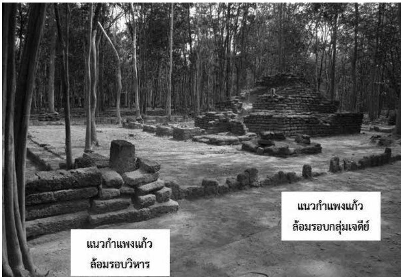
รูปที่ 9 สภาพแนวกำแพงแก้วของวัดมะคอกหลังจากการขุดแต่ง แสดงให้เห็นความแตกต่างระหว่างการก่อแนวกำแพงล้อมรอบกลุ่มเจดีย์ที่ใช้แท่งศิลาแลงปักเรียงต่อกัน กับการก่อแนวกำแพงล้อมรอบวิหารที่ใช้วิธีการวางแท่งศิลาแลงนอนซ้อนขึ้นไป
